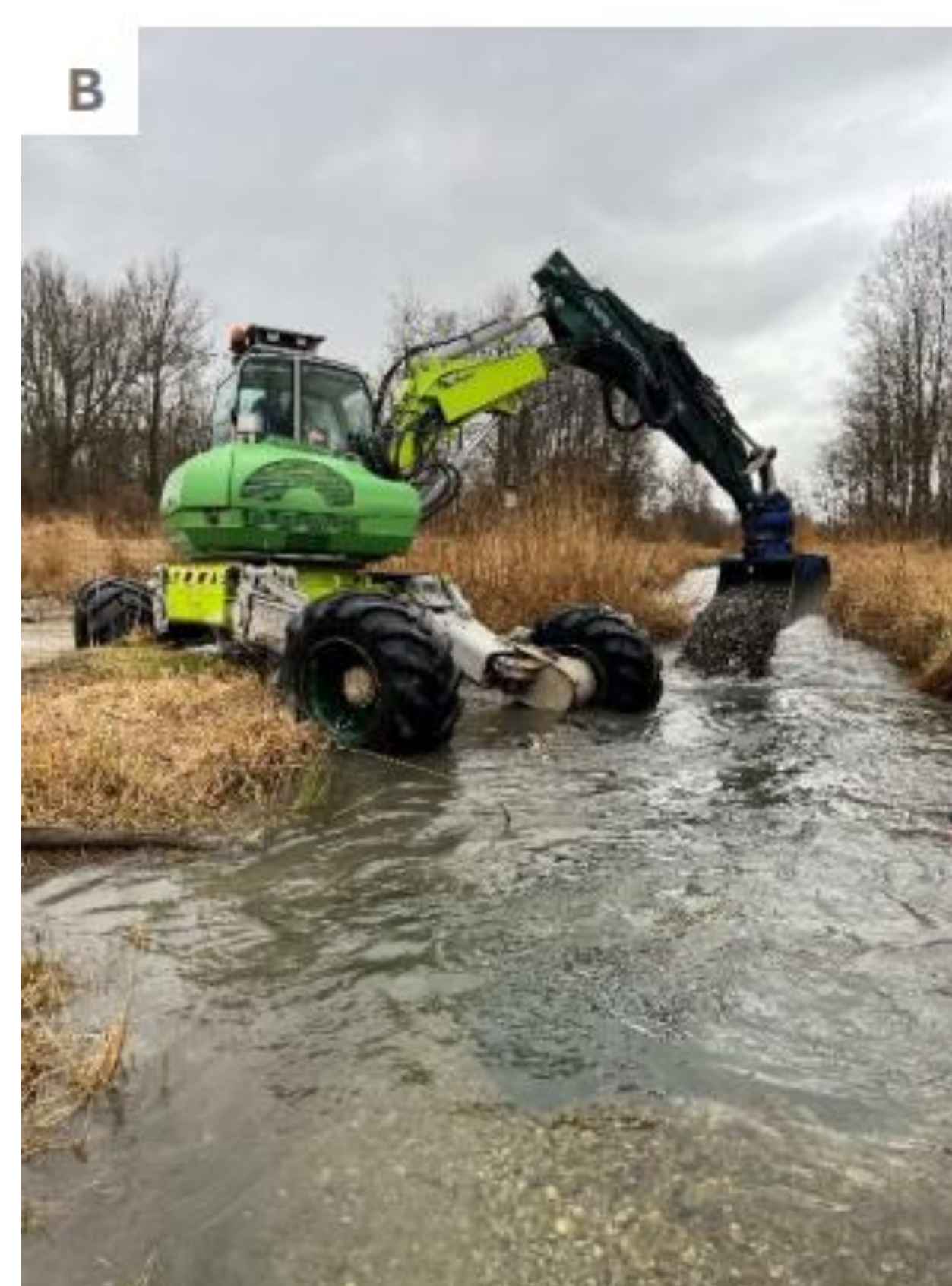
Abbildung 26 Oben links: Laichplatz an Maßnahmenort 1 in der FWH Perach nach der Maßnahmenumsetzung. Oben rechts: Lockerung der Gewässersohle und Kieszugabe an Maßnahmenort 4 (Mündung Fischbach). Unten: Lockerung des Laichplatzes am Maßnahmenort 7 stromab des Borstenfischpasses.
