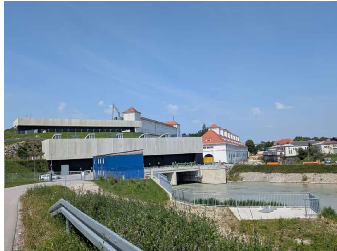
Das neue und alte Kraftwerk in Töging (Foto: Dorena Buchmeier)
