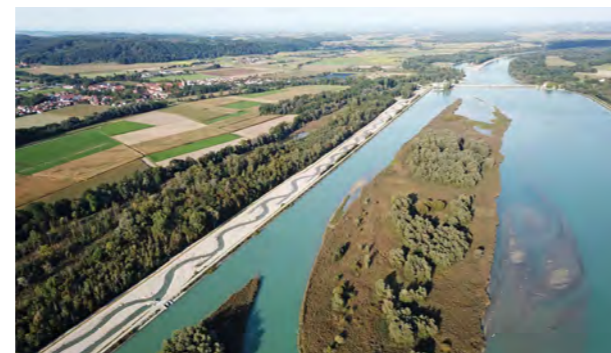
Mit einem großzügigen Umgehungsgrinne entsteht neben dem Stauraum wieder Platz für Arten dynamischer Fließgewässer.
