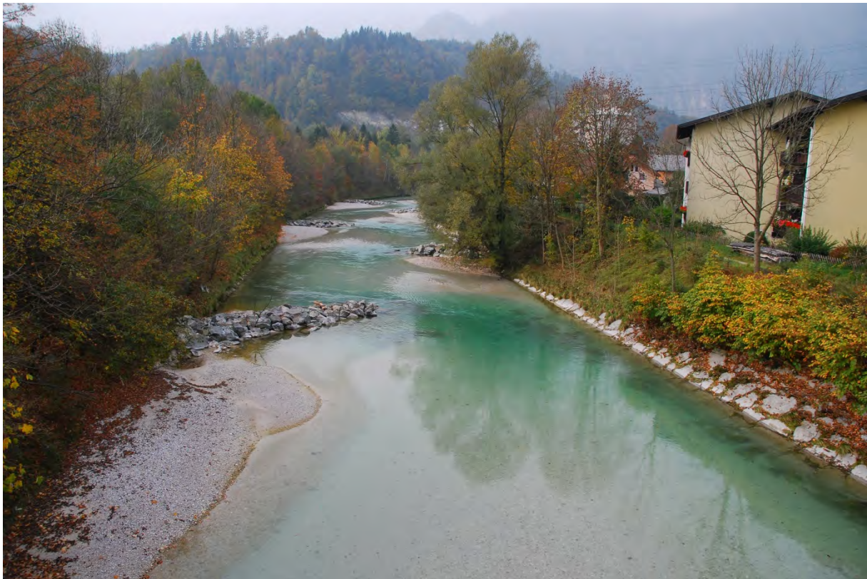
Abbildung 5-3: Strukturierungen der Königsseer Ache im Siedlungsbereich durch Buhnen (Foto: REVITAL)
