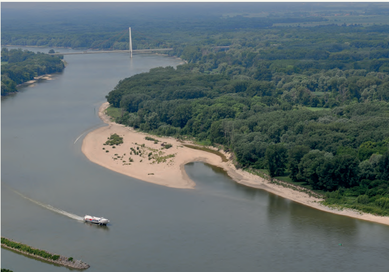
Abb.20: Hinter einer vorgelagerten Insel hat sich nach dem Uferrückbau ein Naturufer ausgebildet (Foto: Egger/WWF)
