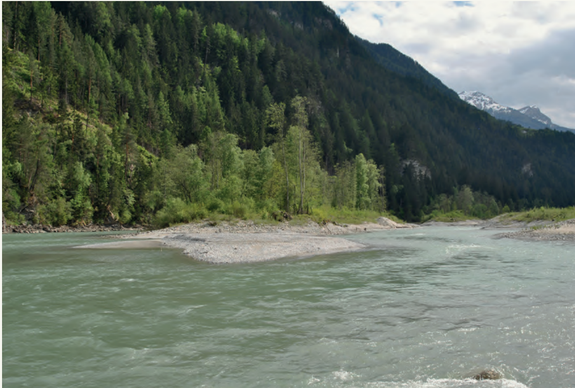
Abb.15: Die fertiggestellte Maßnahme Serfaus in Blickrichtung inaufwärts, links der Hauptstromstrich, rechts ein Durchstich mit verhältnismäßig flachen Uferbereichen. Foto: Tschavoll WWF
