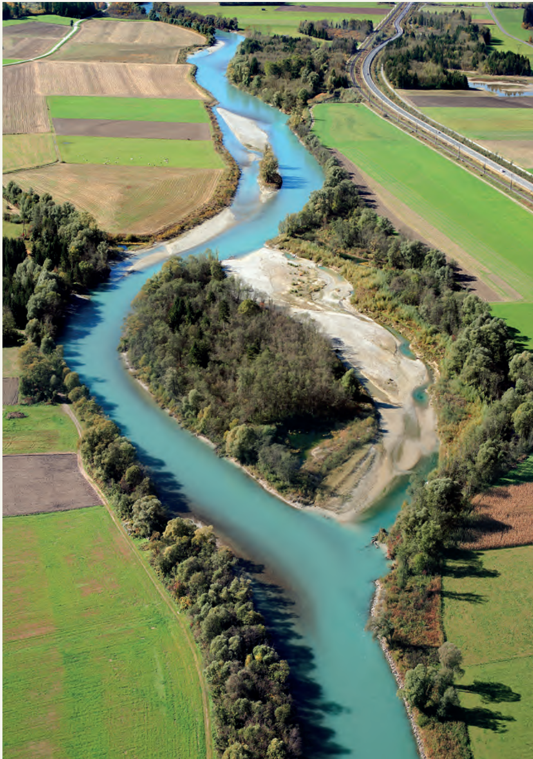
Abb.2: Maßnahmenbereich Drau, Kleblach-Lind nach Maßnahmenumsetzung, Stand 2007 (Quelle: Amt der Kärntner Landesregierung/S. Tichy)
